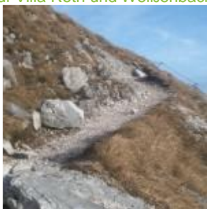
Aufstieg Schoberstein Sicherungen
